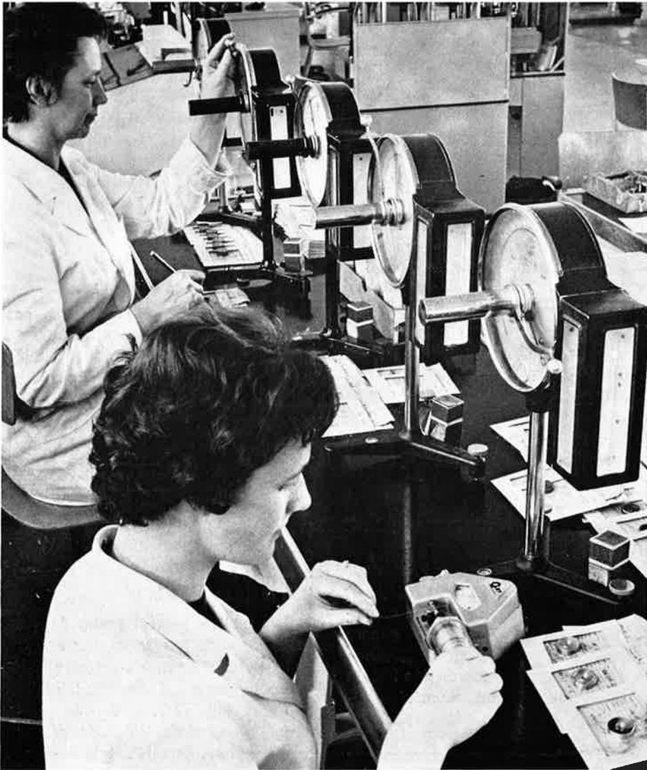
37 Vérification de la cote de l'alésage par détermination d'un fil étiré.
